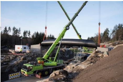
Gang og Sykkelsti Bru, Taraldsrud
